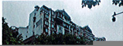
估价对象大楼外观：
