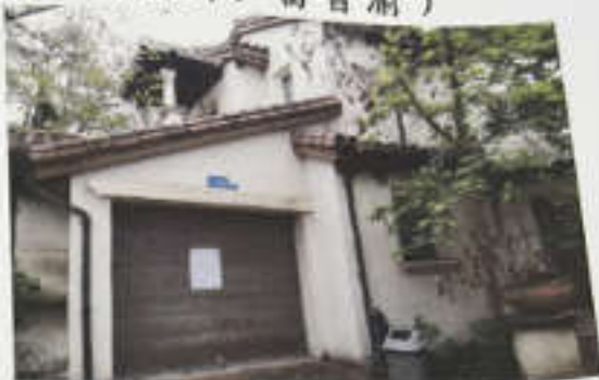
估价对象外观现状
