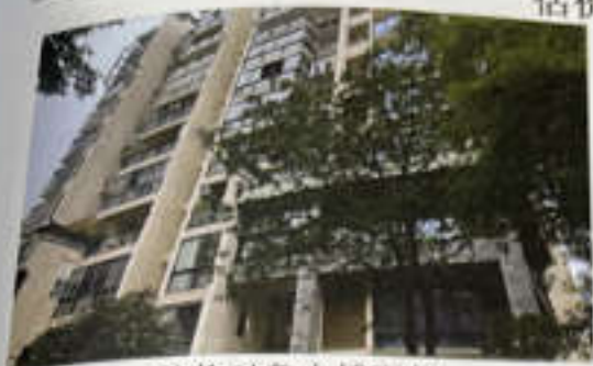
估价对象大楼现状
