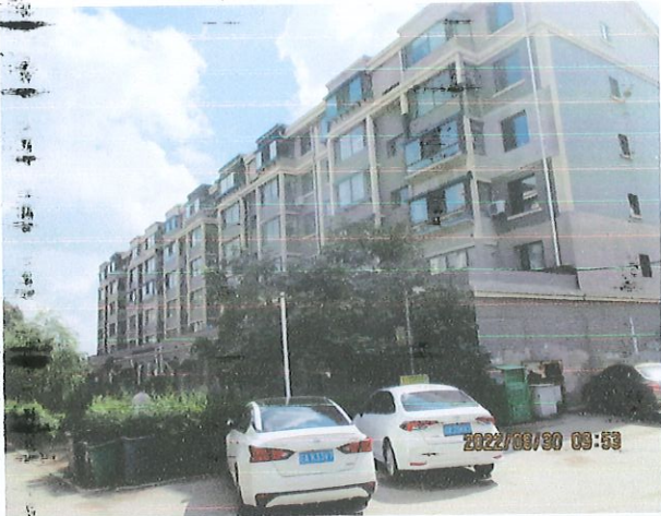
估价对象所在楼外景
