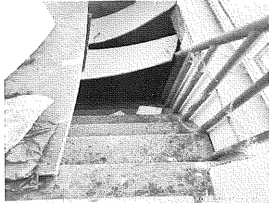
通往地下室楼梯
