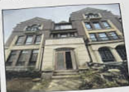
估价对象1建筑物外观
