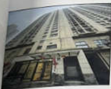
估价对象 5 建筑物外观内部
