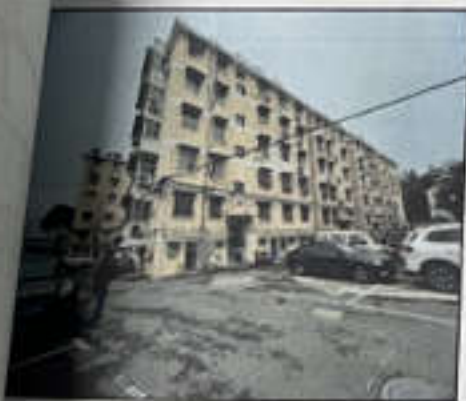
估价对象 6 建筑物外观
