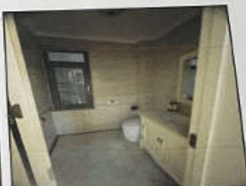
估价对象1第1层内部状况
