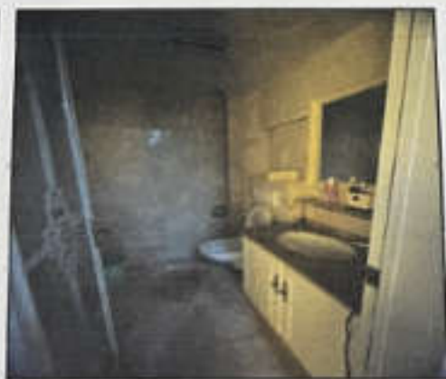
估价对象1第-1层下内部状况
