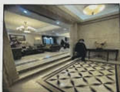
估价对象1第1层内部状况
