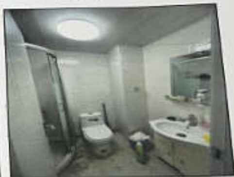
估价对象3内部状况
