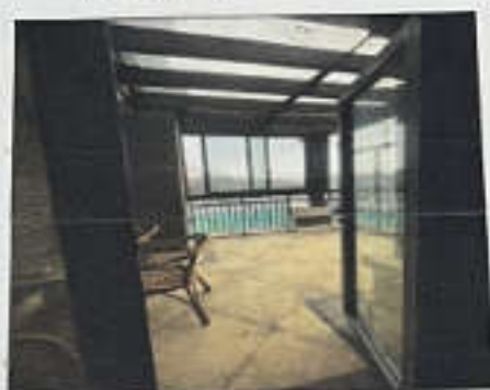
估价对象1第3层内部状况
