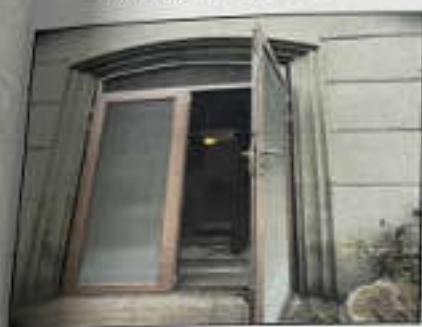
估价对象1第1层内部状况
