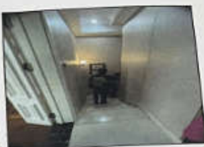
估价对象1第2层内部状况
