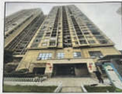
估价对象3建筑物外观
