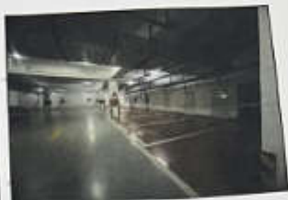
估价对象2临过道状况
