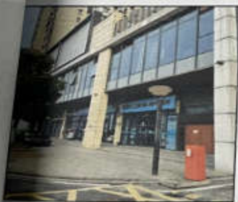
估价对象4建筑物外观
