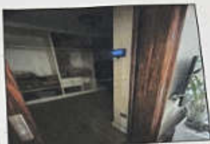
估价对象1第-1层上内部状况
