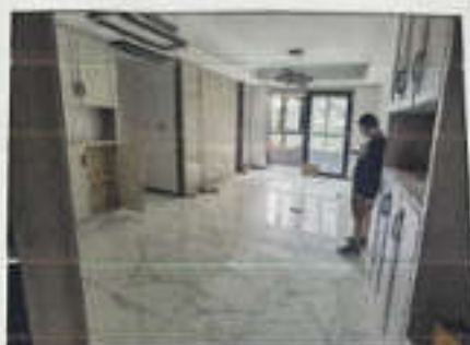
估价对象内部状况
