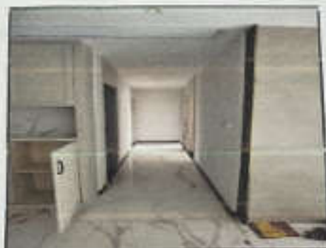
估价对象内部状况
