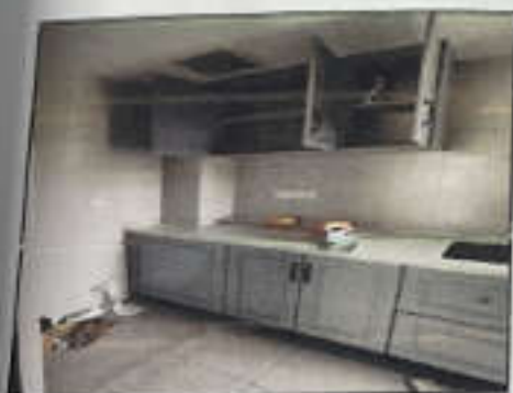
估价对象内部状况
