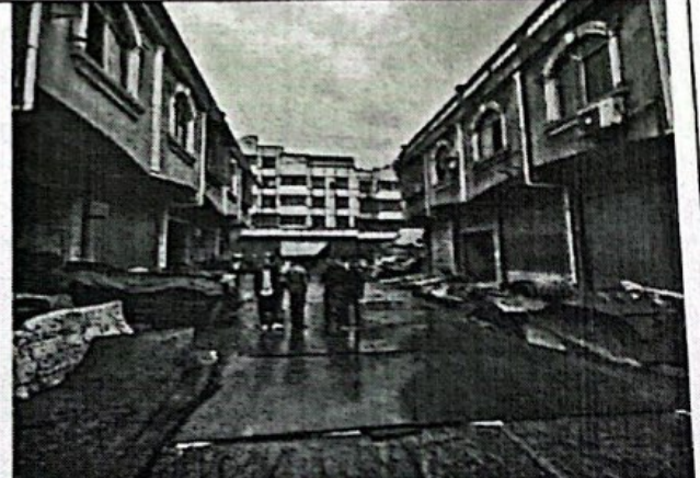
估价对象临街状况
