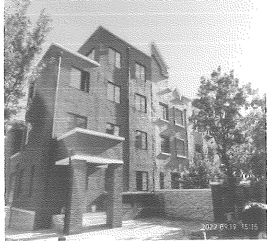
估价对象所在楼外景
