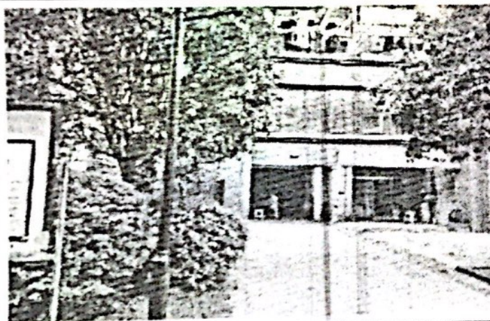
估价对象单元入口
