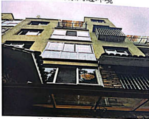
估价对象建筑物外观
