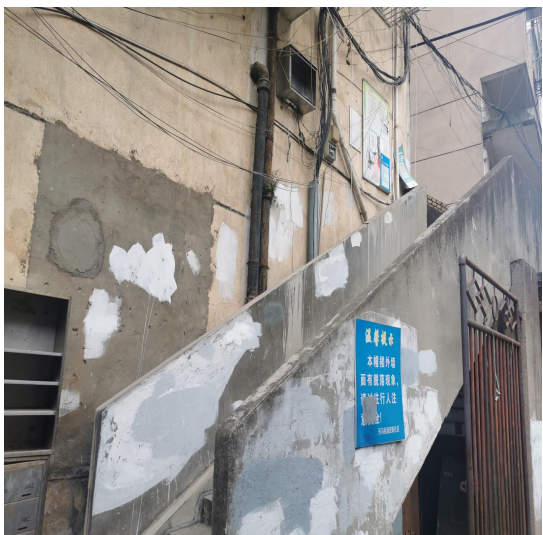
估价对象单元楼梯
