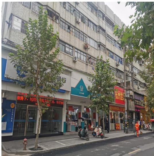
估价对象建筑外立面
