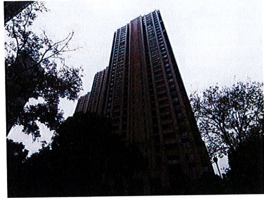
建筑物外立面
