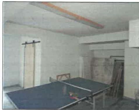
估价对象地下夹层
