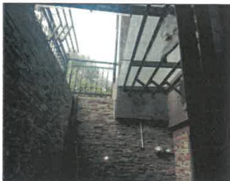
估价对象地下夹层天井
