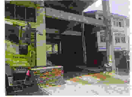
估价对象车行出入口状况
