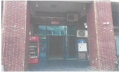
估价对象楼栋出入口
