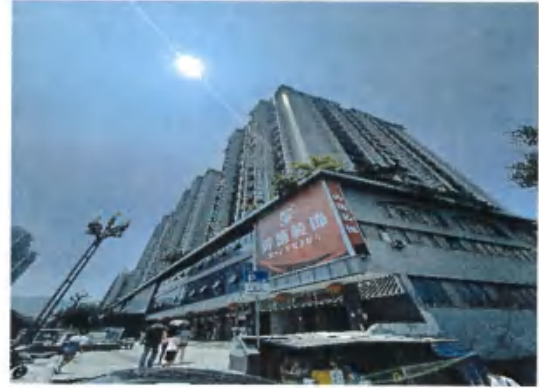
估价对象大楼外观
