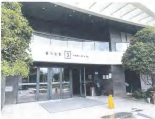
估价对象单元入口
