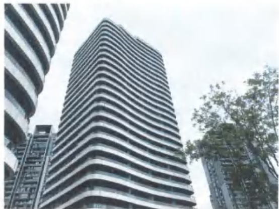
估价对象外观现状
