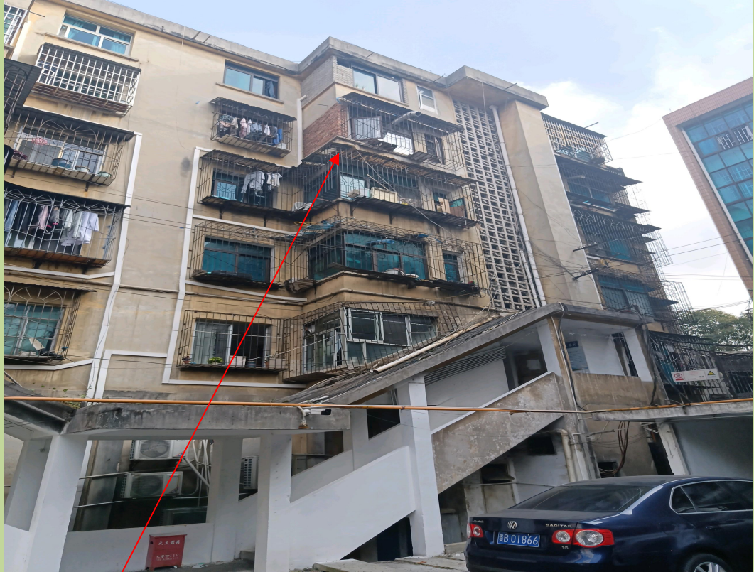
估价对象所在楼栋外观
