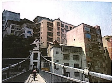
估价对象建筑物外观
