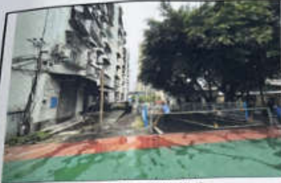
估价对象 2 临路状况
