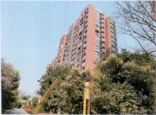
估价对象外观现状
