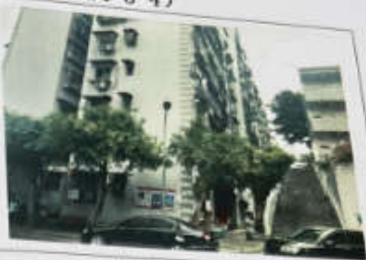
估价对象楼栋外观
