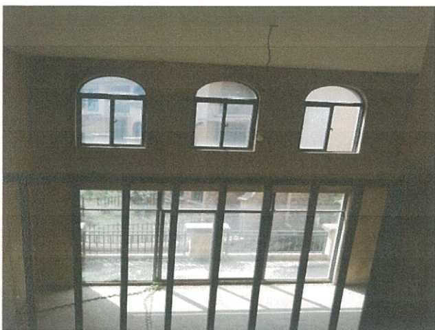
估价对象室内
