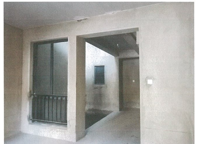
估价对象室内
