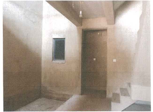
估价对象室内
