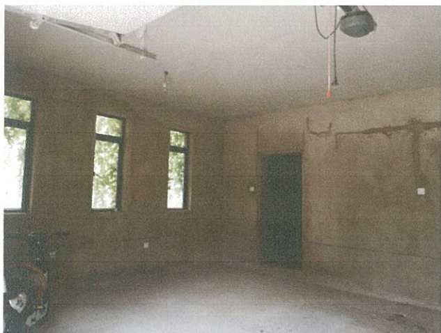
估价对象室内
