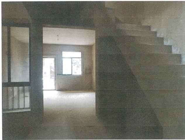
估价对象室内
