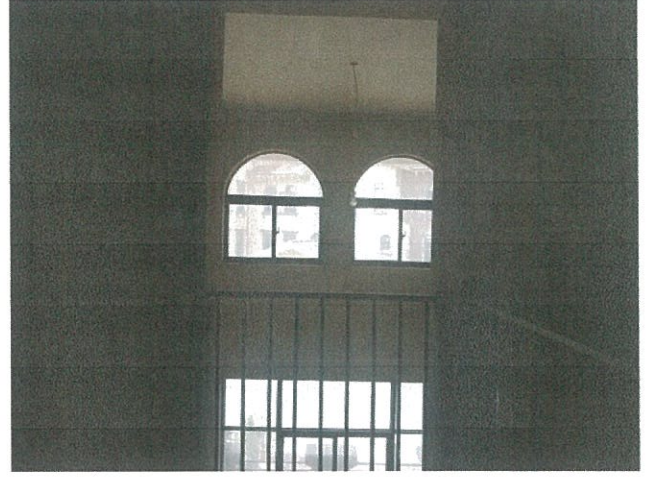
估价对象室内
