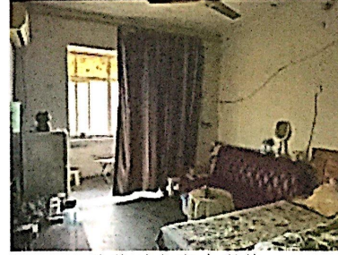
估价对象室内现状
