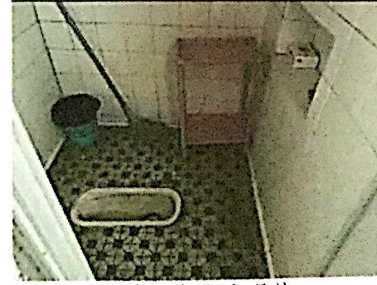
估价对象室内现状
