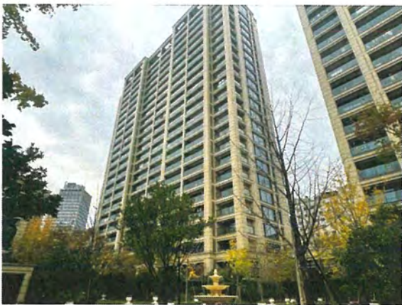
建筑物外观(南向)
