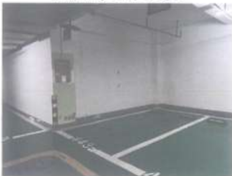
估价对象 3 内部现状
