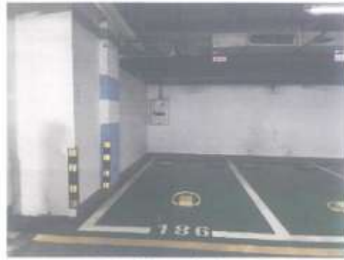
估价对象 2 内部现状
