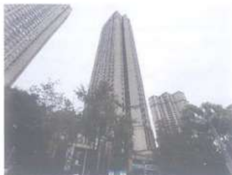
估价对象 1-3 所在楼幢外观现状
