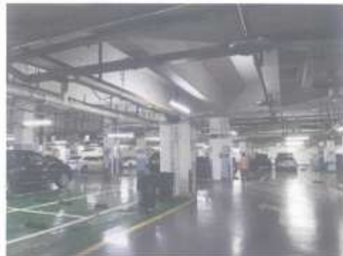
估价对象 2 所在楼层现状
