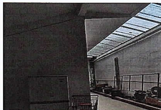
估价对象内部
