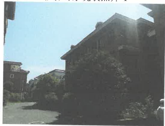
估价对象现状照片 6
