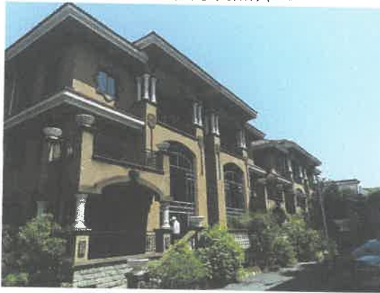
估价对象现状照片 3
