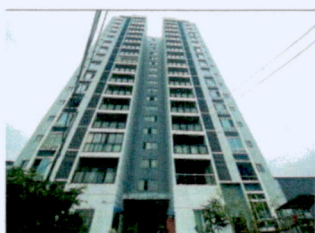
现状照片一：估价对象 1-3 外观
