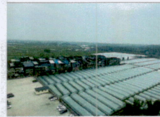
现状照片十六：估价对象 3 景观
