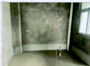
现状照片四：估价对象 1 厨房
