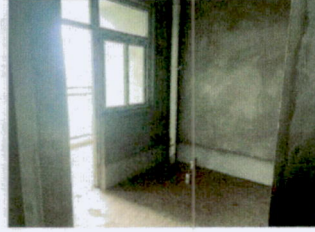
现状照片十：估价对象 2 厨房
