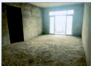
现状照片三：估价对象 1 客厅
