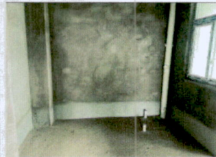
现状照片四：估价对象 1 厨房
