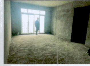
现状照片八：估价对象 2 客厅
