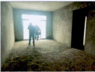
现状照片十三：估价对象 3 客厅
