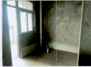
现状照片十四：估价对象 3 厨房
