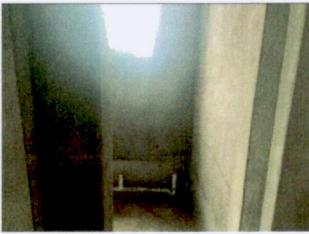
现状照片十一：估价对象 2 卫生间
