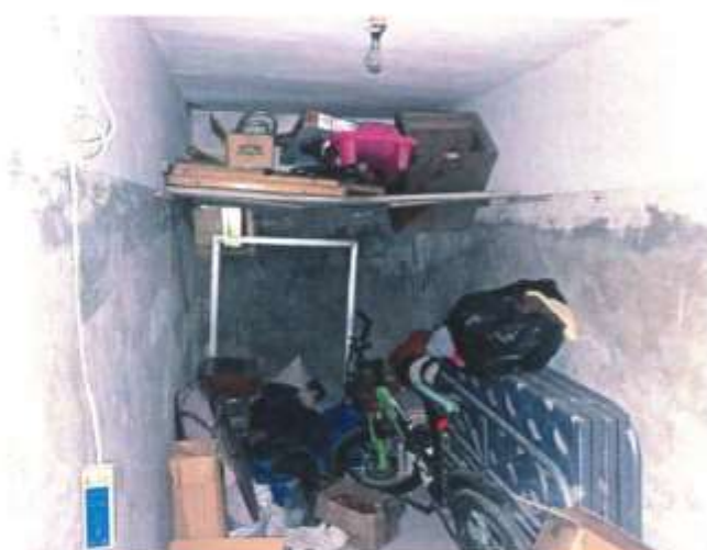
储藏室室内状况
