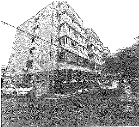
估价对象所在楼外景
