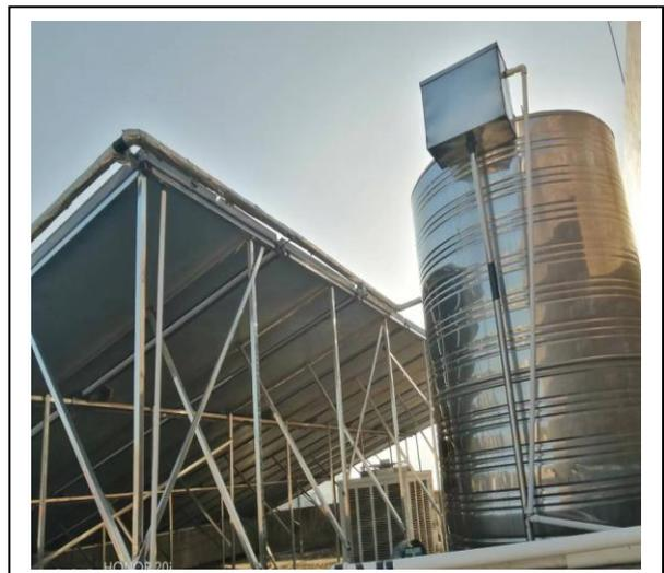
图 25：楼顶的不锈钢水塔
