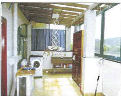
估价对象三层自搭自建阳台
