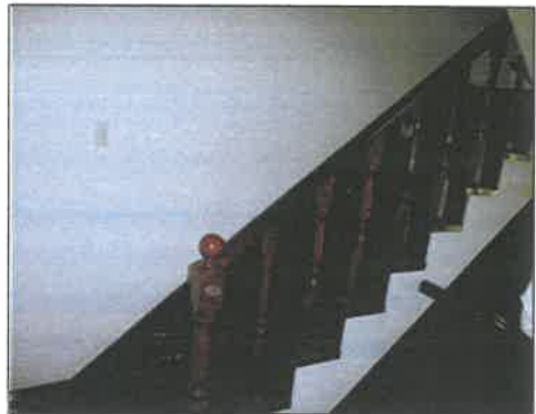
估价对象一层内部楼梯
