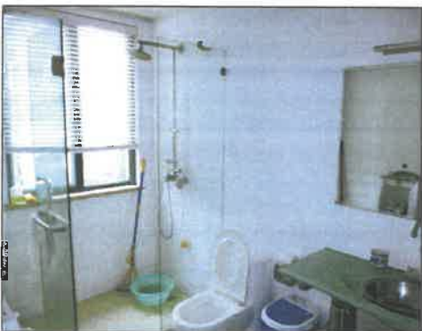
估价对象二层卫生间
