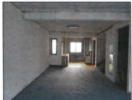
估价对象5层内部1
