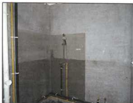
估价对象6层内部4
