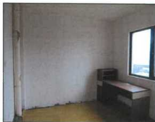
估价对象6层内部3
