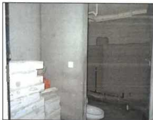
估价对象5层内部3
