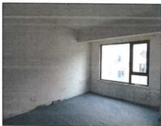
估价对象5层内部2
