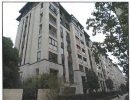
估价对象建筑物外观
