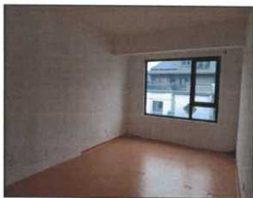
估价对象6层内部2
