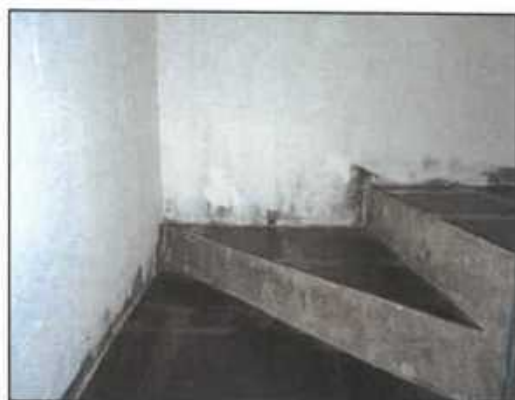
估价对象内部楼梯
