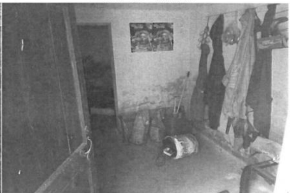
◆架空层内部状况◆
