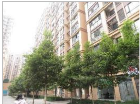
估价对象楼栋外观
