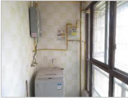
估价对象室内状况
