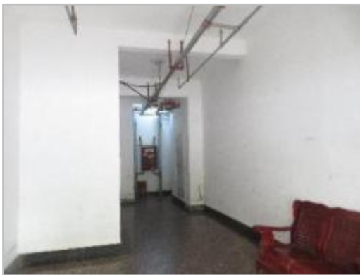
估价对象楼栋入口状况
