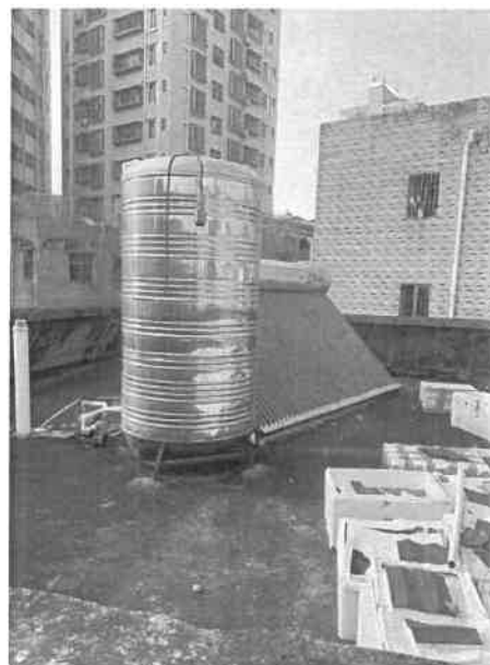
现场勘查图片 36
