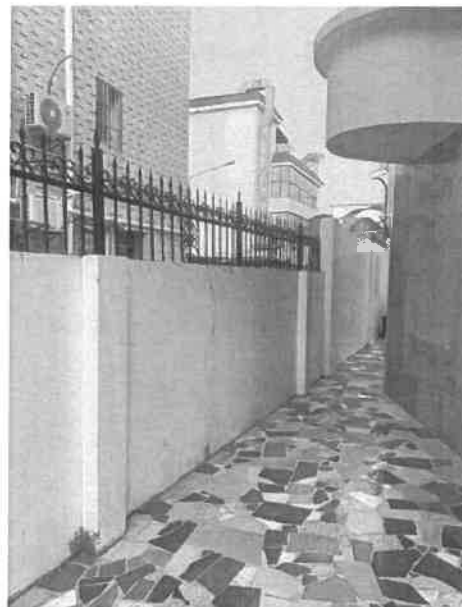
现场勘查图片 4
