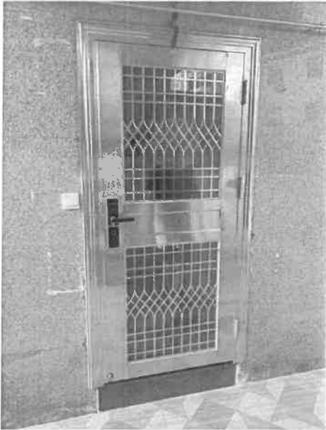
现场勘查图片 33
