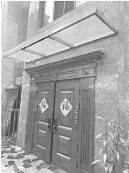
现场勘查图片 7
