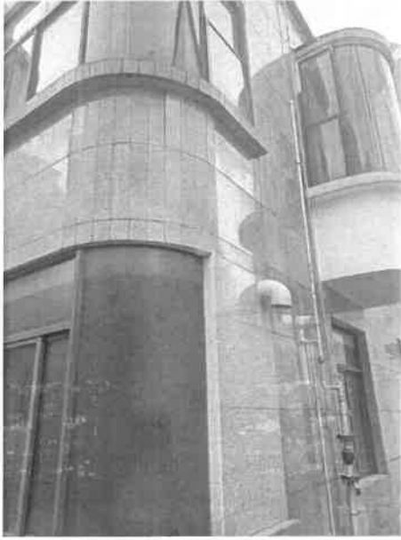
现场勘查图片 5
