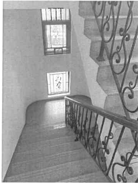
现场勘查图片 18
