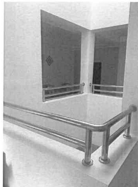
现场勘查图片 20
