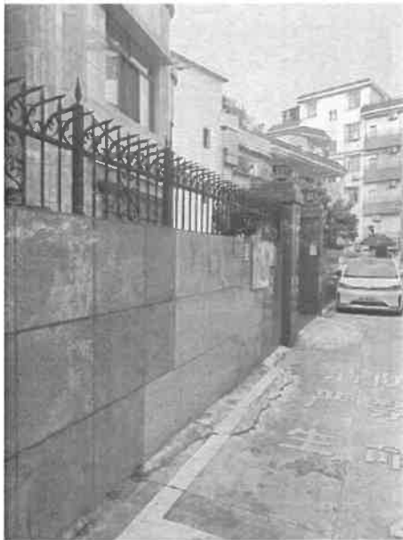
现场勘查图片 39
