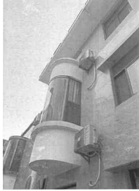
现场勘查图片 6
