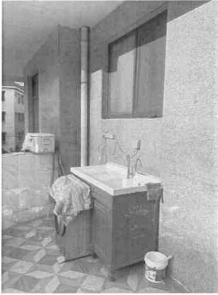
现场勘查图片 37
