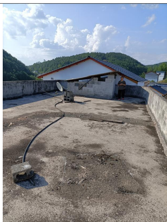
估价对象屋顶
