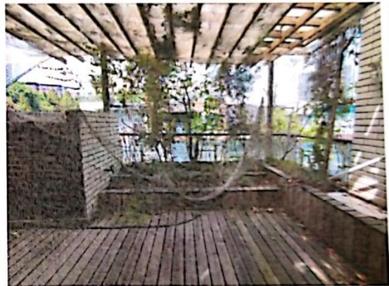
室内第 2 层现状
