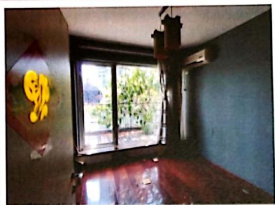
室内第 2 层现状
