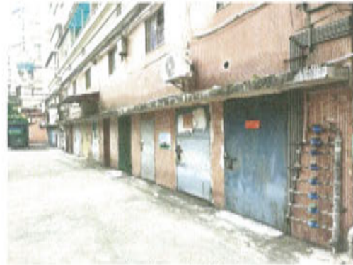
13#车房（绿色门） 江门市新会区会城葵兴路18号3座13#车房
