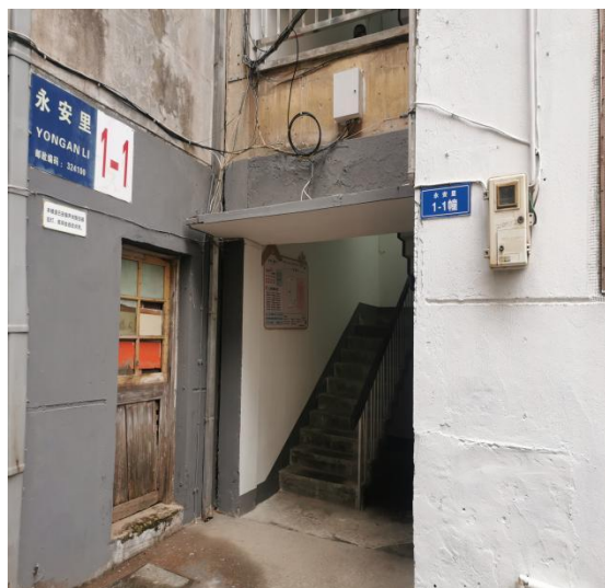
估价对象单元入口
