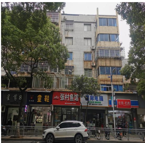
估价对象建筑外立面（北）
