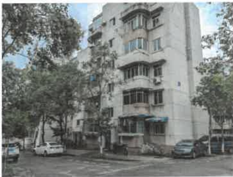
◆估价对象楼栋外观
