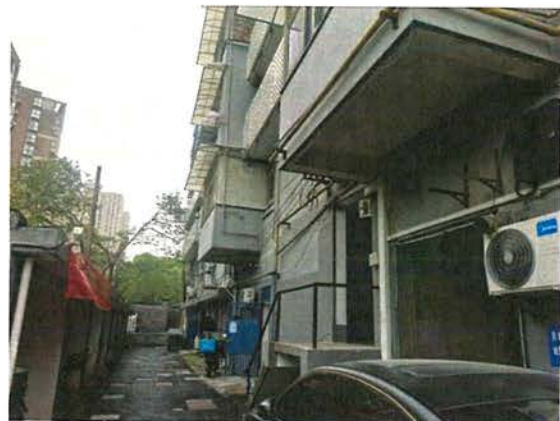
小区北面单元入口状况
