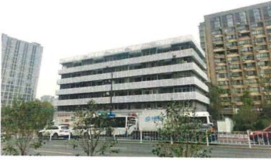
建筑物外立面南面
