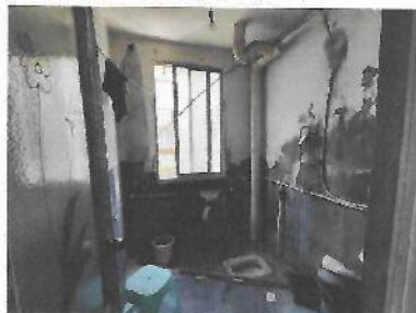
估价对象室内现状
