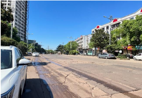
小区临路状况 1 (阳光大道)
