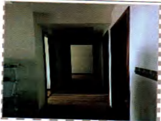
估价对象室内状况
