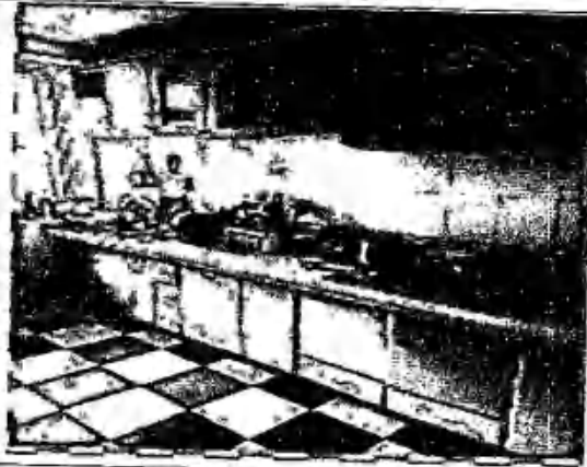
估价对象室内状况
