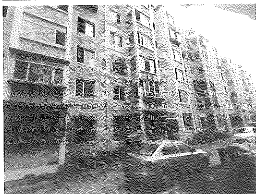
估价对象所在楼幢照片
