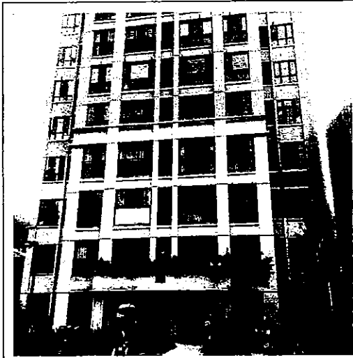
图片 1: 估价对象现状
